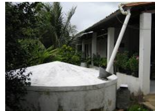
Captación de agua lluvia
