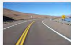
Interrupción de caminos
