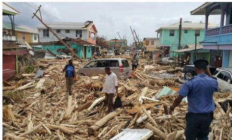
Roseau, capital de Dominica después del huracán Maria, Sept. 2017
